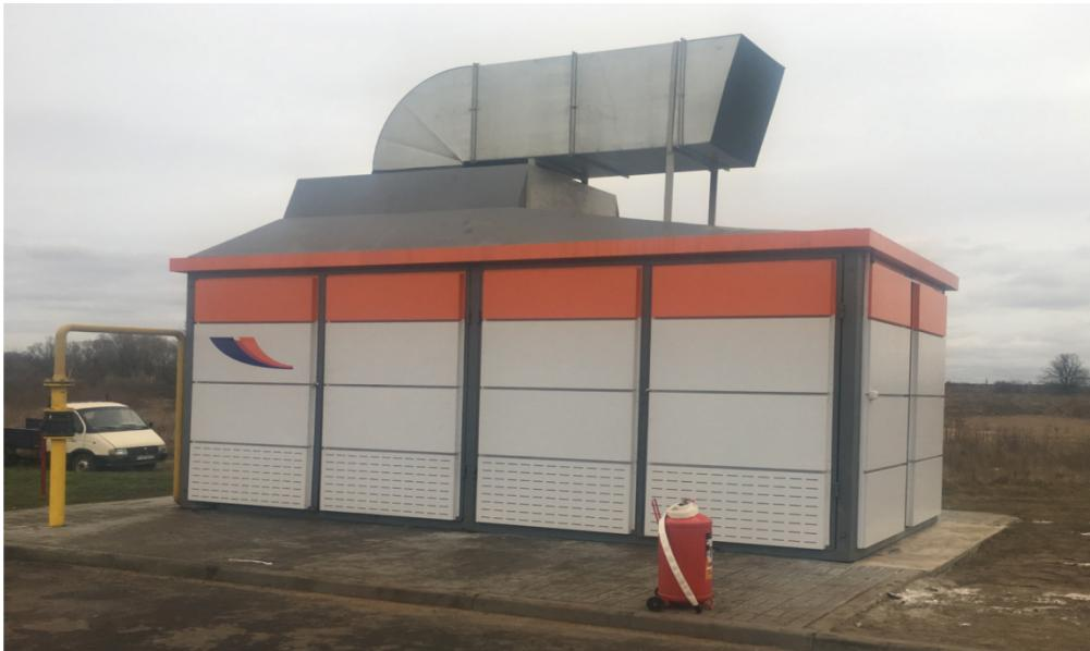
Блок-бокс – это АГНКС компактного блочного исполнения, которая особенно подходит для размещения на участках с ограниченной площадью. Предназначен для размещения установки компрессорной и осушки газа высокого давления, элементов автоматики и управления, с целью защиты их от атмосферных явлений и обеспечения эксплуатации всего оборудования при низких температурах окружающей среды.
