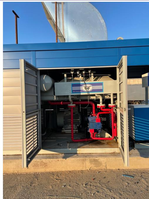
Блок компрессорный совместно с фильтрами входными, колонками газораздаточными, компенсаторами давления, установкой осушки газа высокого давления, блоком входных кранов, системой межблочных газопроводов и кабелей используется в составе автомобильной газонаполнительной компрессорной станции (АГНКС).
