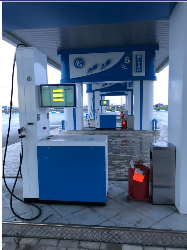
Колонки газораздаточные представляют собой технологическое оборудование для заправки автомобилей и автобусов сжатым природным газом, используемым в качестве моторного топлива. Они просты в установке, эксплуатации и обслуживании. Конструкция и качество компонентов гарантирует высокую скорость и безопасность заправки, а также высокую точность измерений.
