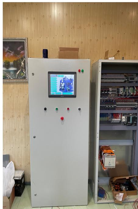
Работа станции полностью автоматизирована. Система автоматики обеспечивает контроль параметров станции, автоматическое включение и выключение, а также автоматическое отключение станции при выходе параметров за допустимые пределы.
